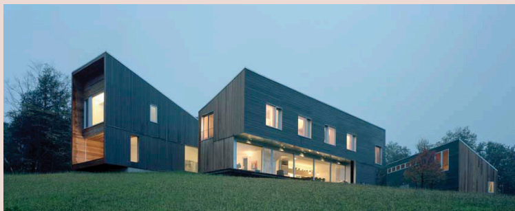
Referentie: verschillende gebouwen in gelijke architectuur
