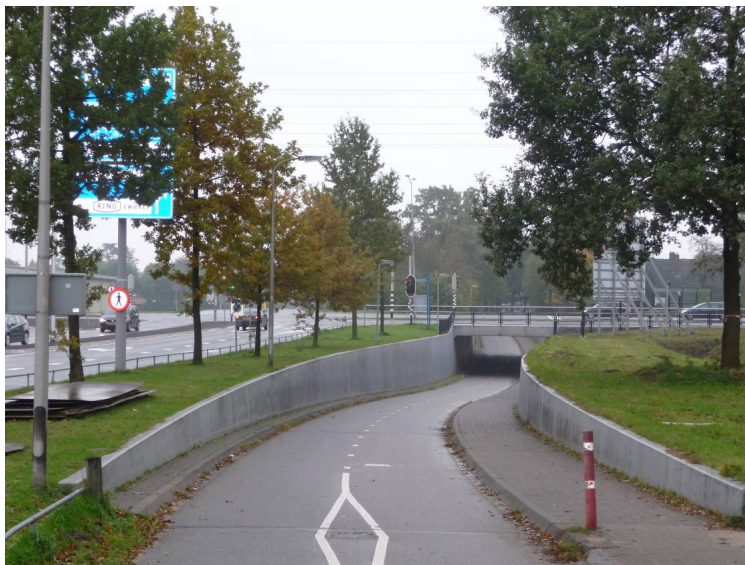
Figuur 6.2.5 Fiets- en voetgangerstunnel onder de Weezebeeksingel, langs de Stadionlaan
