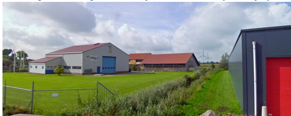
Afbeelding 2.4: situering Staalbouw Dijkstra en Klein Bouw (achterzijde)
