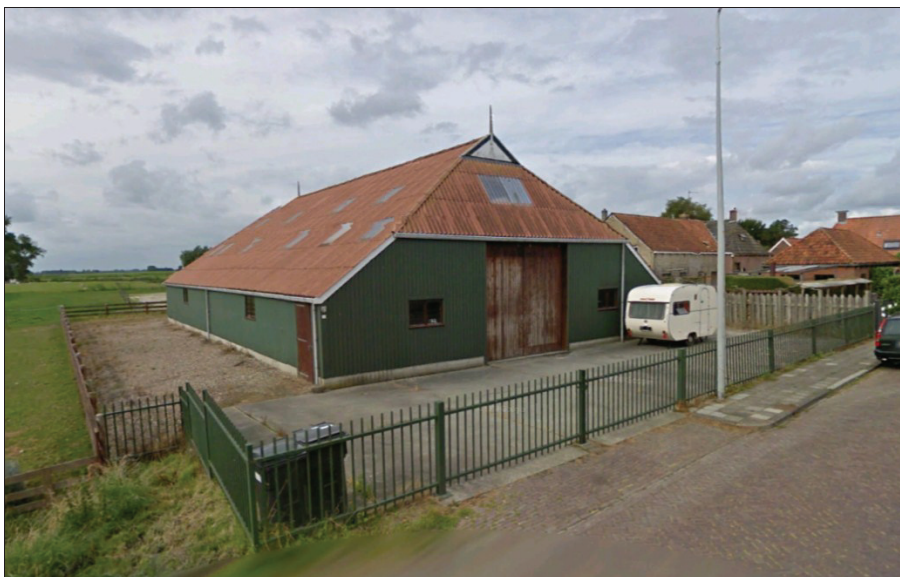
Figuur 12. Plangebied vanuit het westen (Bron: Google Earth, 2012)
