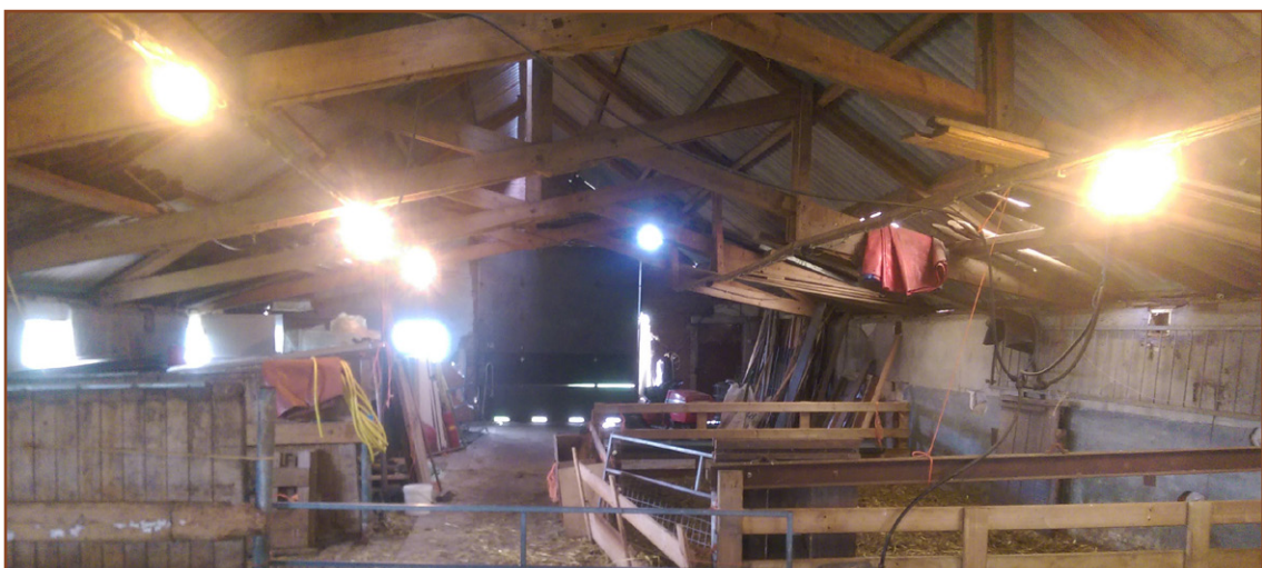
Afb. 3.5: Binnenzijde stal. Sporen van uilen of Steenmarter ontbreken. Geschikte verblijfplaatsen voor vleermuizen ontbreken. Huismussen komen elders op het erf voor maar nestelen niet in de stal.
