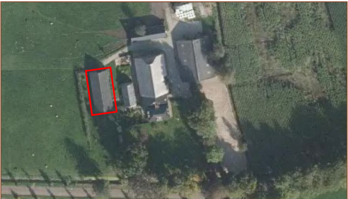
Afb. 1.2: Luchtopname erf Oosterboerweg 101. Rood kader = te slopen varkensstal. Bron ondergrond: PDOK.
