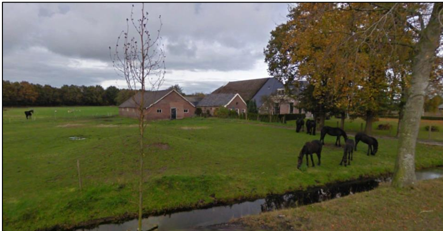
Afbeelding 6. Het huidige erf, met links de varkensschuur, in het midden het stookhuisje en rechts het waardevolle woonhuis.
