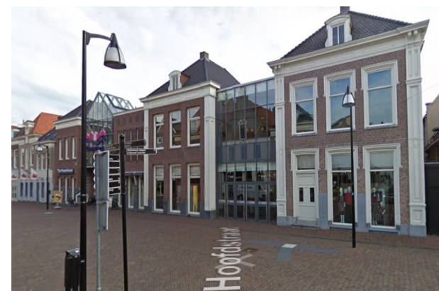
Het gevelfront is in het project Keyzerstroom bij de herstructurering opgedeeld in meerdere 'percelen'.
