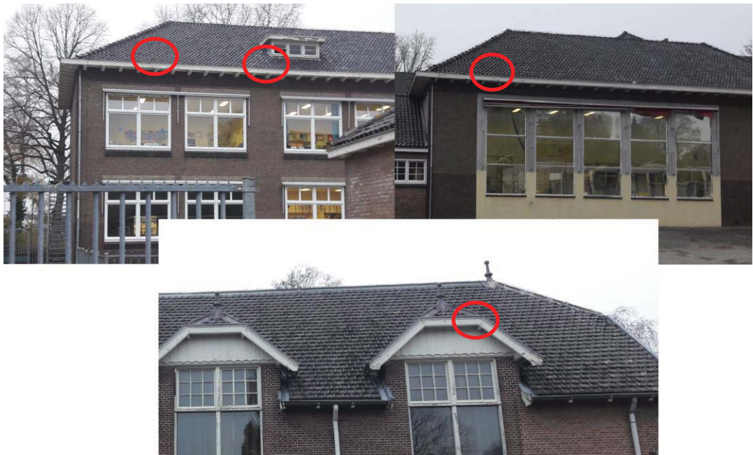
Figuur 4.1 Locatie vastgestelde nestplaatsen Huismus (rood omcirkeld). Boven de nestlocaties bij de Zuiderschool. Onder: nestlocatie gymzaal.
