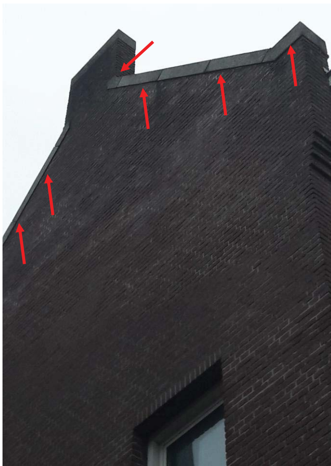
Figuur 4.2 Aanzicht westelijke gevel van de aanbouw. De rode pijlen geven mogelijk invlieglocaties weer van Gewone dwerg vleermuis in de oostelijke gevel van de aanbouw.
