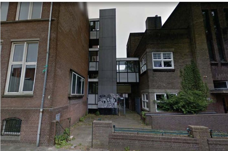
Ontsierende loopbrug en liftschacht aan de oostzijde van het schoolgebouw.
