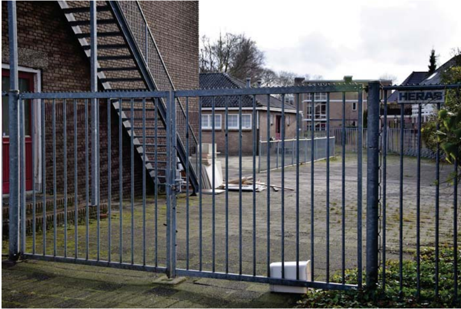
Westzijde schoolgebouw met blik op het schoolplein en hekwerken.
