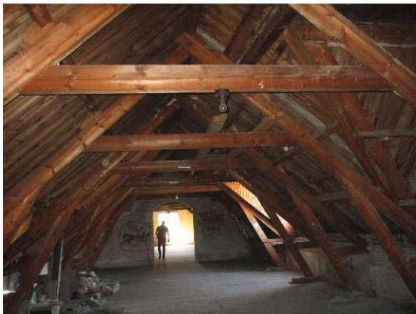
De zolderverdieping uit drie bouwperiodes; links op de voorgrond de resten van de oude trapgevel uit 1881/1882, die gesloopt is in 1913/1915
