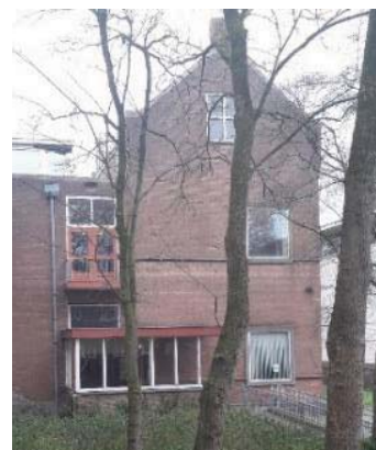
De kopse gevel met aanbouw
