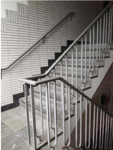
De trap vanaf de begane grond
