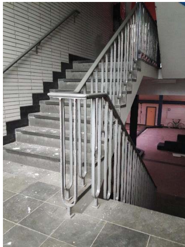
De trap naar de 1 ste verdieping
