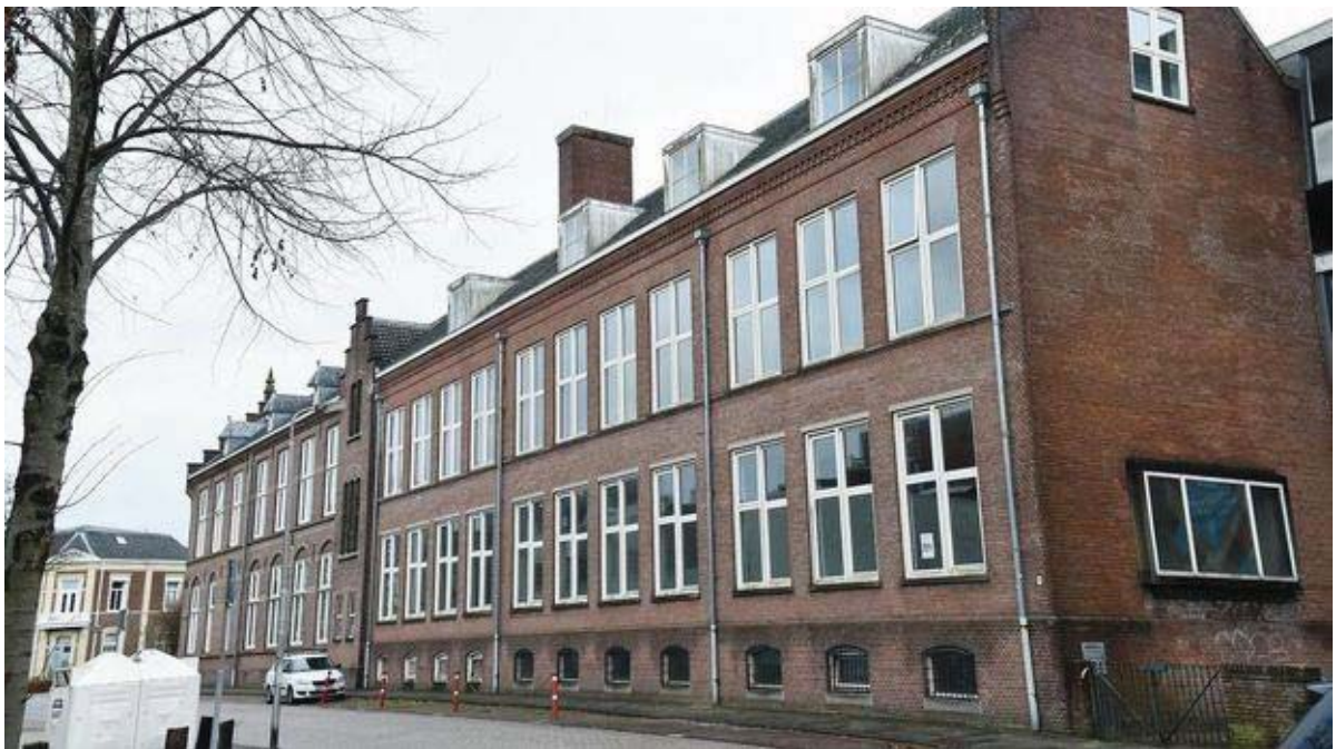
De lange wand aan de noordgevel met duidelijk zichtbaar de kopse gevel als overgang naar de bouw uit de zestiger jaren, die volledig onderkelderd is
