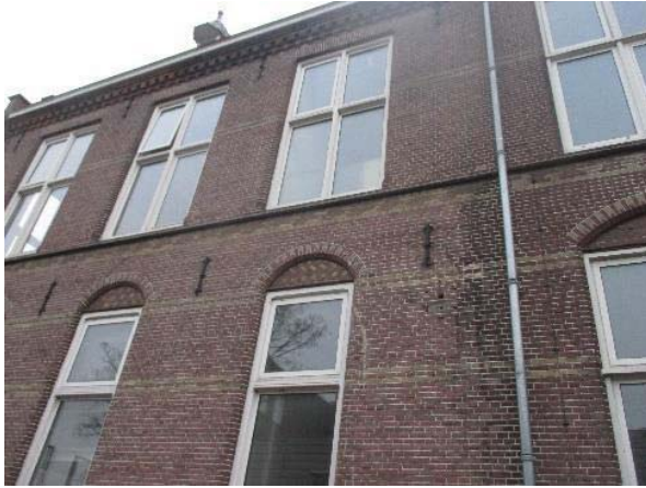
Op de plek van de regenpijp is de overgang van de oorspronkelijke bouw en die van '13/'15
