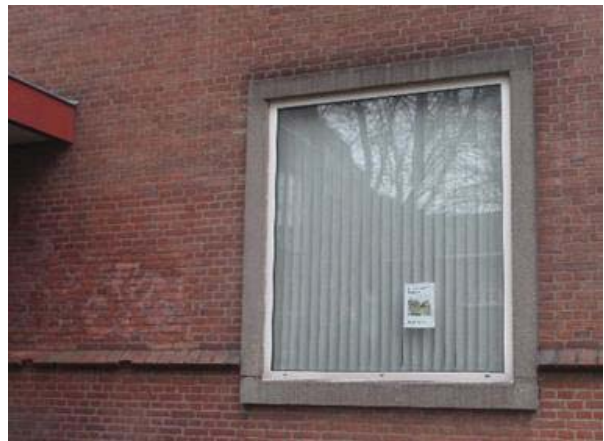
Een raam in de kopse gevel, bestaande uit vier betonnen prefab-elementen
