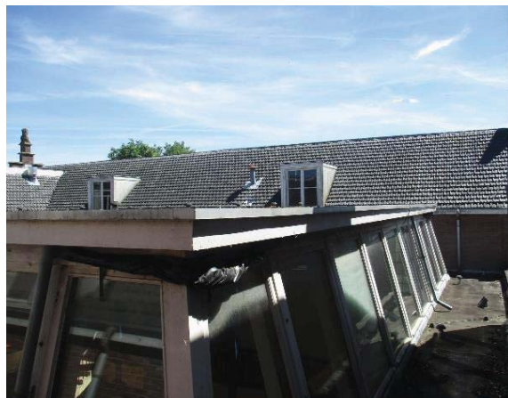
De dakopbouw van het atrium met veel glas
