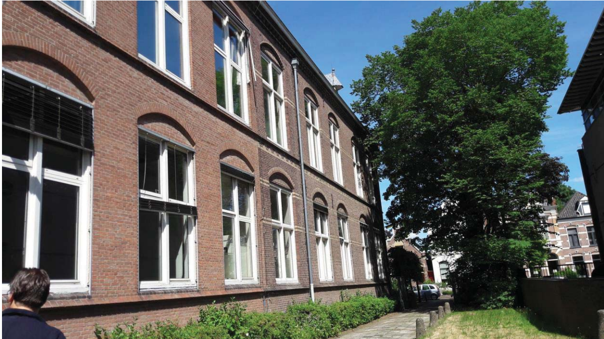
Aan de straatzijde de zuidgevel met de 4 raamkozijnen. Naast de regenpijp de bescheiden uitbreiding van Dirk Monsma uit 1915 in dezelfde stijl en links de "nieuwbouw" uit 1959 met 2x 3 ramen op een rij
