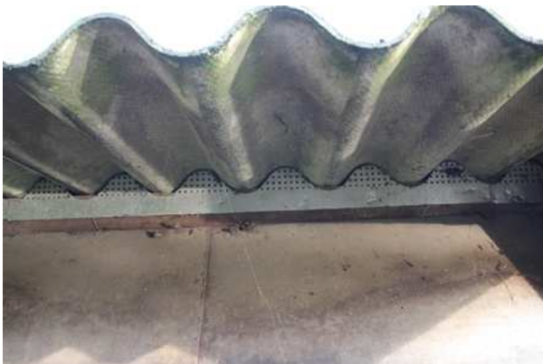
De holle ruimte tussen golfplaat en dakisolatie vormt een geschikte verblijfplaats voor steenmarters. Deze ruimte is bij de stallen in het onderzoeksgebied afgesloten en dus ongeschikt als verblijfplaats voor marters.
