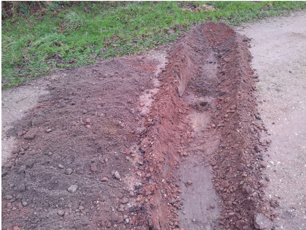
Overzicht sleuf en uitgeharkt materiaal
