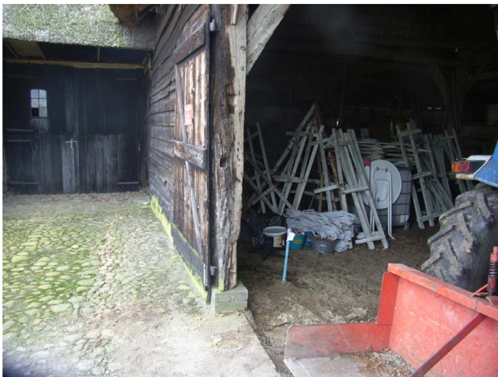
Deellocatie A: voormalige bovengrondse dieseltank
