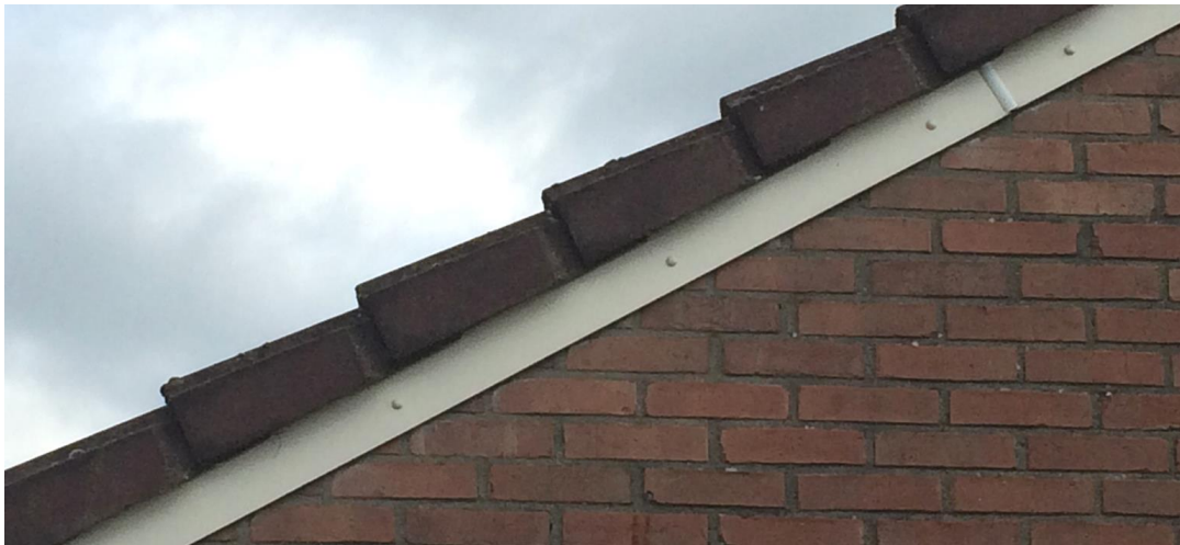
Figuur 5 De gevels zijn afgewerkt met trespas daklijsten.
