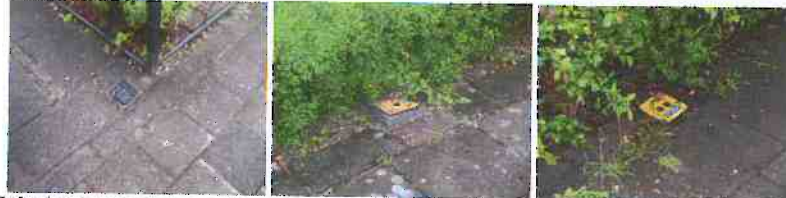
Foto: bestaande peilbuizen
