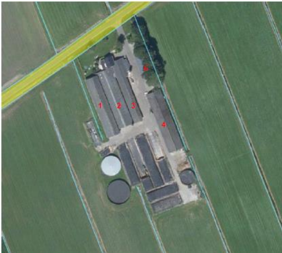
Figuur 2: luchtfoto van het bedrijfsperceel (inclusief nummering van de stallen)
