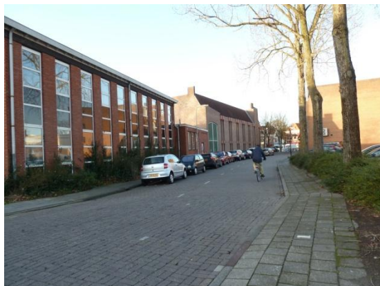
Foto 3. De straat tussen het parkeerterrein en de te slopen bebouwing aan de westkant
