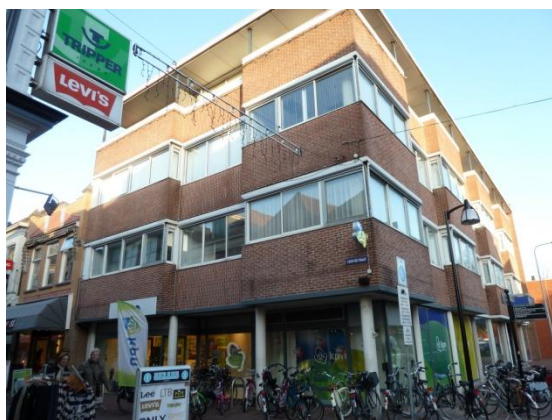
Foto 6. Te slopen of te renoveren winkelpand
