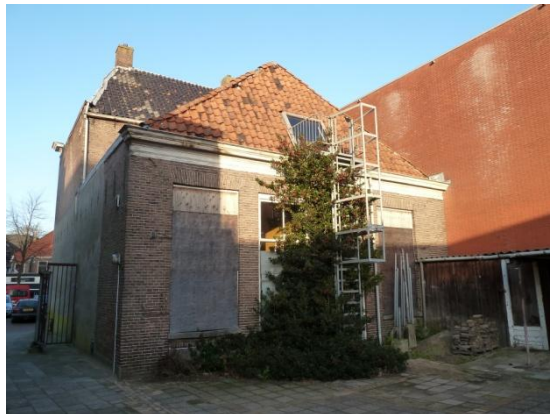
Foto 5. Te slopen woning aan de noordzijde van het plangebied
