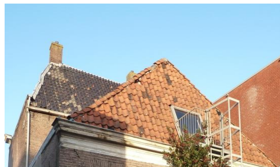
Foto 8. Onder de dakpannen van o.a. deze woning mogelijke broedplaatsen huismus en/of gierzwaluw
