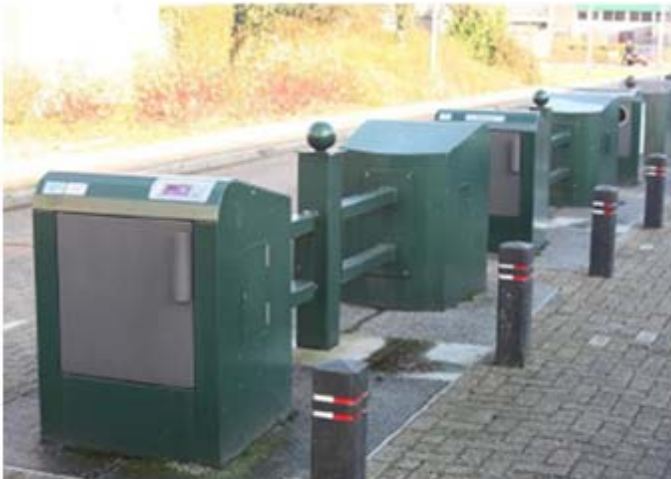
Herplaatsen bestaande ondergrondse containers
