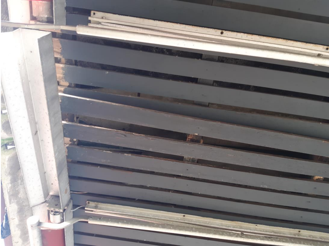
Figuur 4.4 Potentiële nestlocaties voor huismus in het Reggersoord gebouw.
