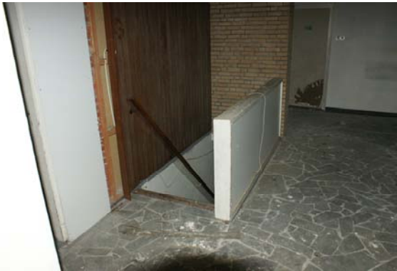
Toegang tot kelder
