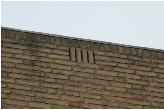
Ventilatiegaten als toegang naar spouw
