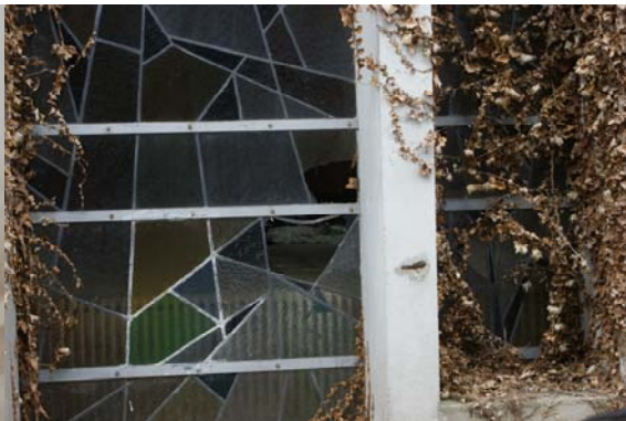
Gaten in glas in lood raamwerk aan straatzijde
