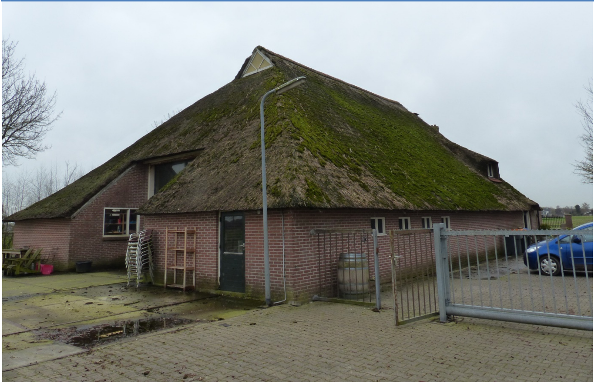
Overzicht locatie. Duidelijk is het dichtgemaakte uilenbord te zien.
