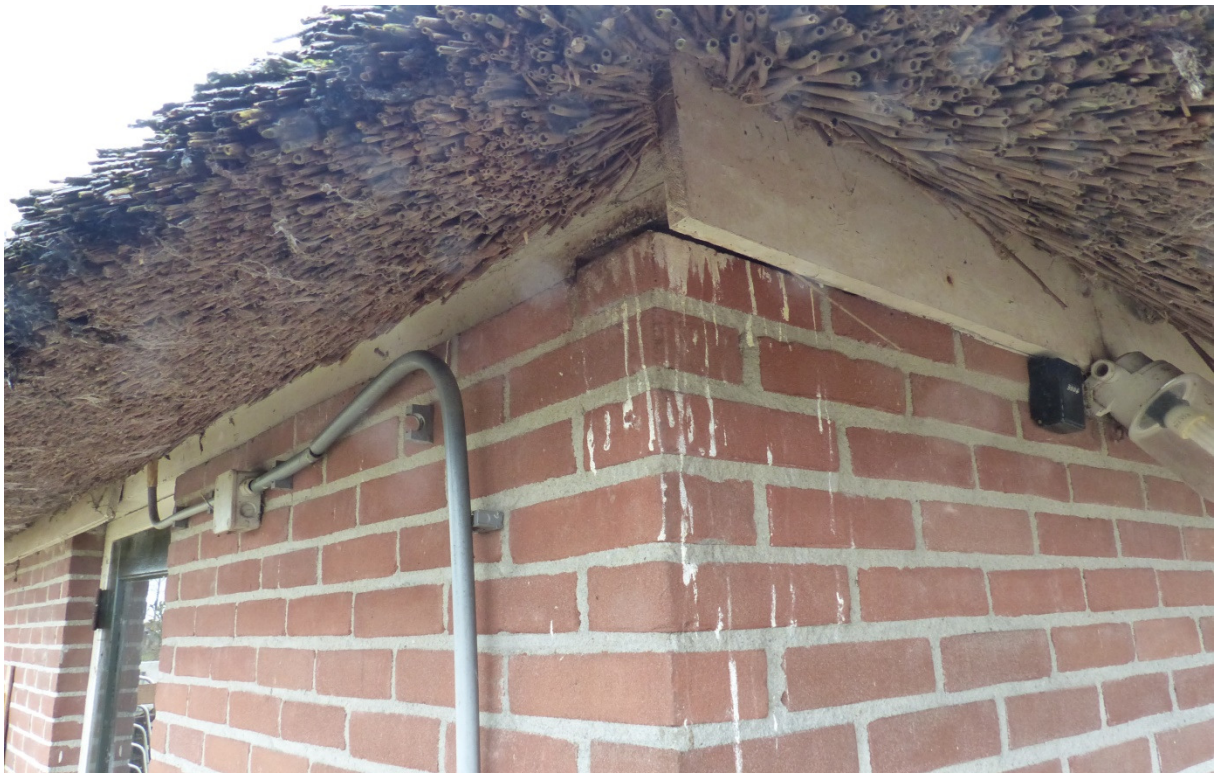
Uitwerpselen van vogels. Zeer waarschijnlijk betreft het hier een rustplaats en geen broedplaats.
