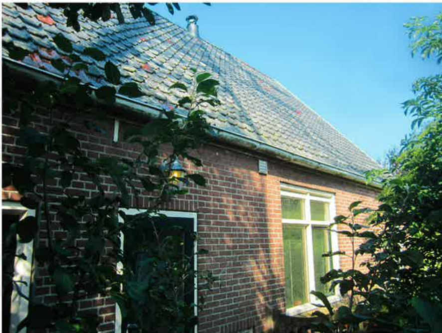
Foto 8, Overzichtsfoto van de buitenzijde van het asbestvrije woonhuis.
