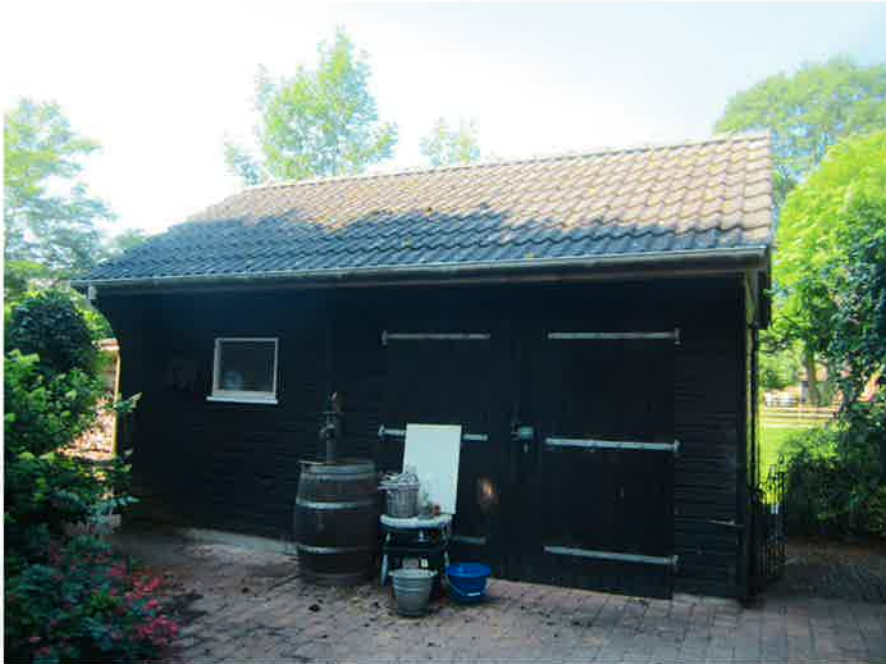
Foto 11, Overzichtsfoto van de asbestvrije houten schuur achter het woonhuis.
