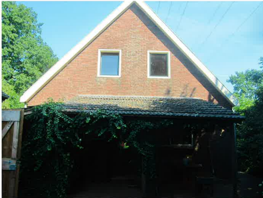
Foto 9, Overzichtsfoto van de buitenzijde van het asbestvrije woonhuis.
