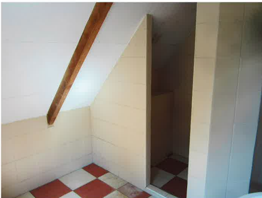
Foto 6, Overzichtsfoto van de asbestvrije badkamer op de 1 e verdieping van het woonhuis.
