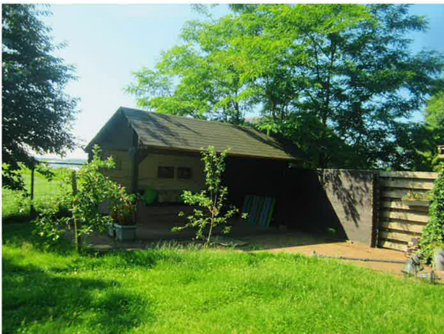
Foto 12, Overzichtsfoto van het asbestvrije tuinhuis in de achtertuin van het woonhuis.
