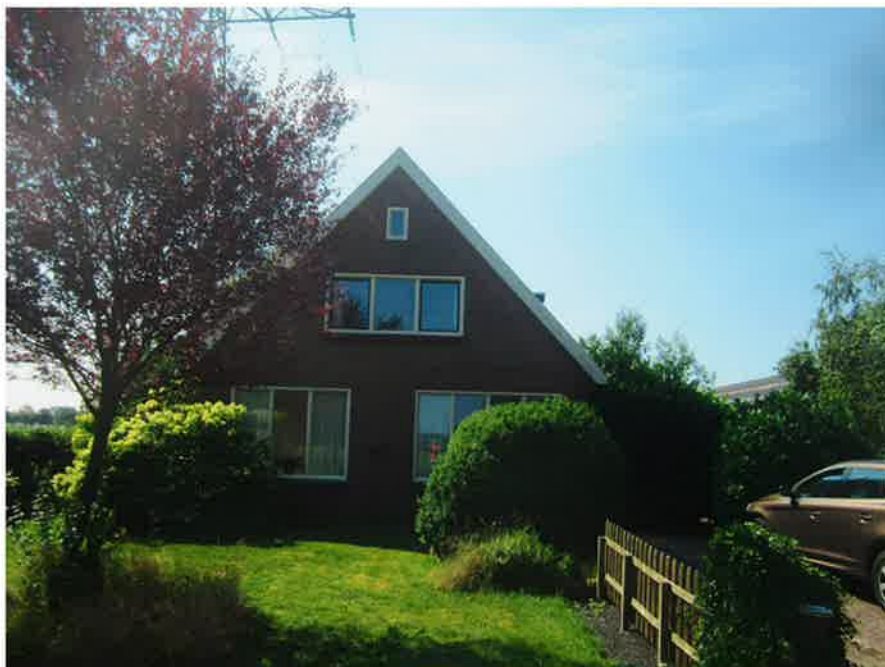
Foto 10, Overzichtsfoto van de buitenzijde van het asbestvrije woonhuis.
