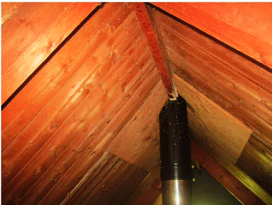
Foto 4, Overzichtsfoto van de asbestvrije houten dakconstructie van de woning.
