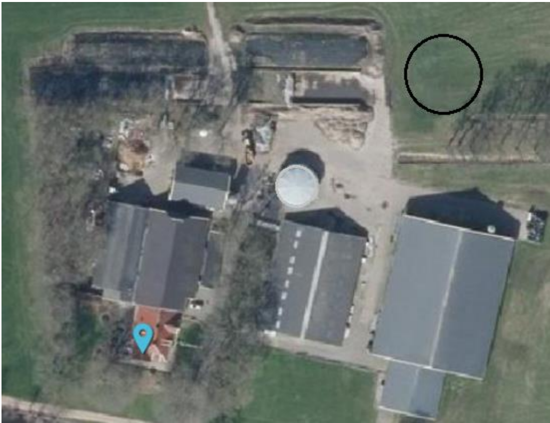
Fig. 4: locatie van de nieuwe mestsilos achter de ligboxenstal in het verlengde van de sleufsilos
