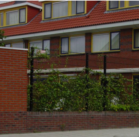
Combinatie tuinmuur en gaas met klimop als erfafscheiding privé - openbaar
