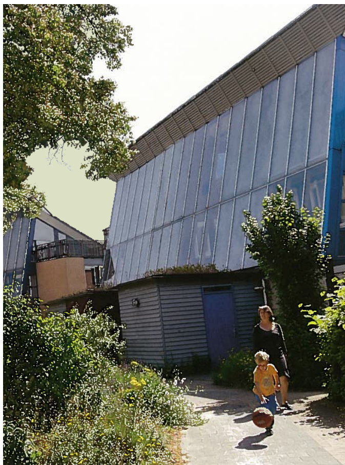
glas op het zuiden (zonne-energie)
