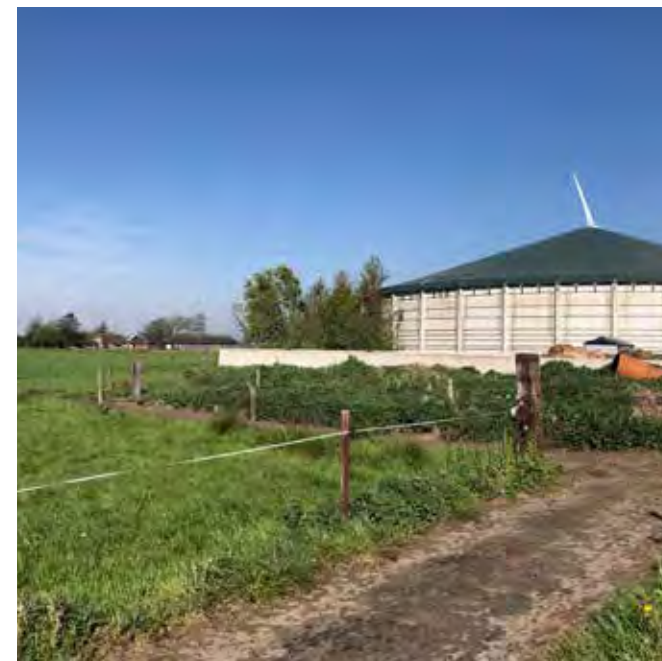
bestaande mestsilo/vaste mest opslag
