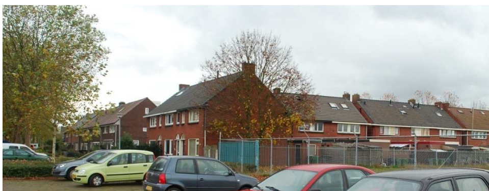
aansluiting op de bebouwingswand van de Ezingerbuurt
