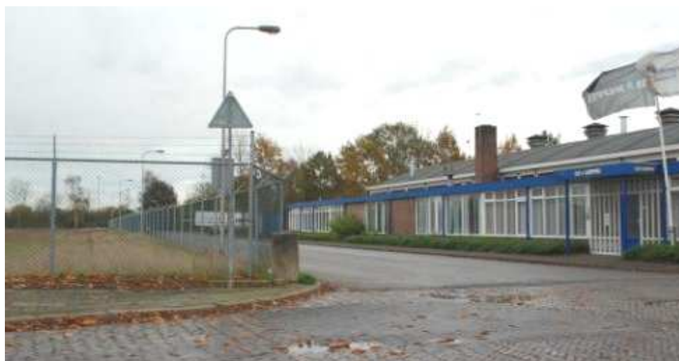
de bestaande begrenzing richting bedrijfsbebouwing
