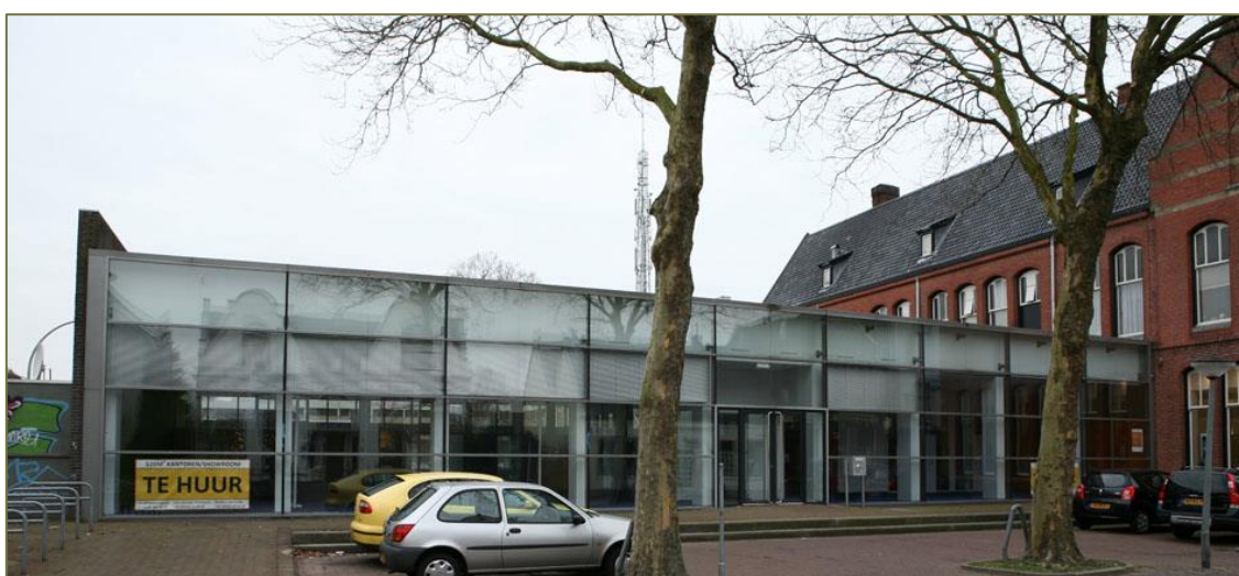
Figuur 2a: Huidige situatie, rechts op de foto het voormalige postkantoor.
