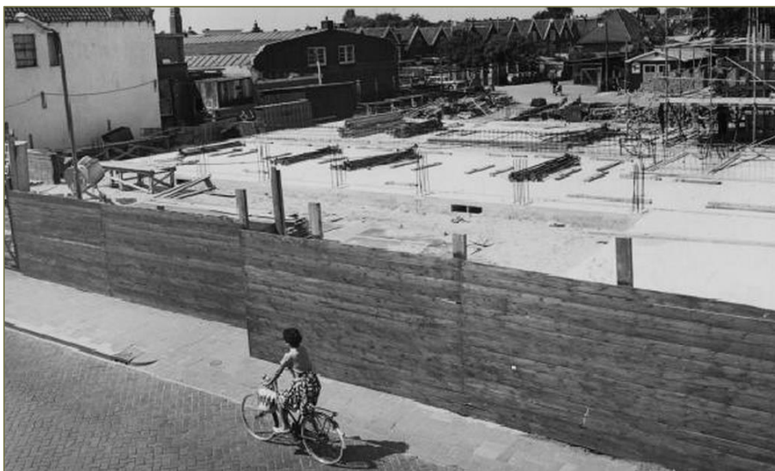
Figuur 10: 1966: De kerk en de omliggende gebouwen zijn afgebroken en hebben plaats moeten maken voor een grote bouwput. Rechts op de foto bevindt zich het oude postkantoor (buiten beeld). Waarschijnlijk is bij dit gebeuren de bodem sterk verstoord geraakt.
