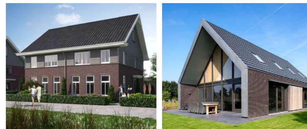
Gerealiseerde woningbouw in Broeklanden 4
