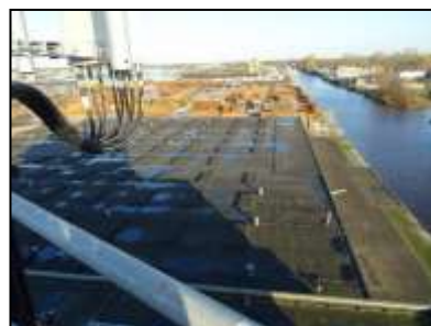
Figuur 8. Het dak van de bebouwing vanuit zuidwestelijk aanzicht.
