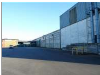
Figuur 3. Het noordelijk aanzicht van de bebouwing op de onderzoekslocatie.
