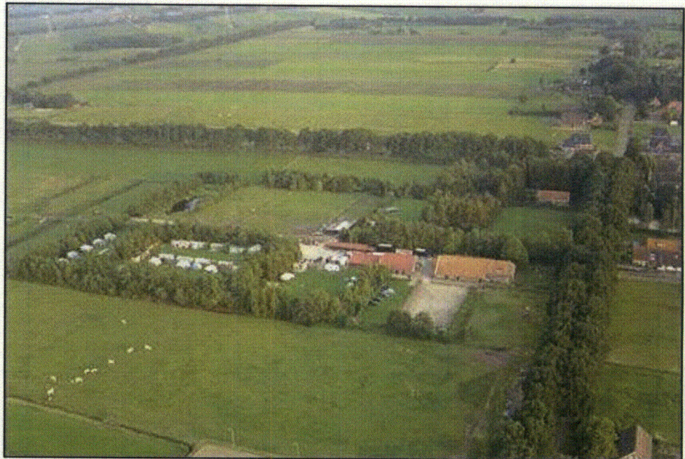
Figuur 2.4 Luchtfoto van het perceel aan de Zuideropgaande (Bron: website camping Nieuw Moscou)
