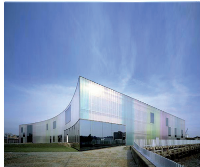
rodeca gevelbekleding (max. 40% van het geveloppervlak ) kleuren: wit, blauw, geel, rood, groen
