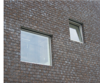
dubbel waalformaat bruin/zwart (alleen in deel A en B) (concordia 0154126) (min 50% en max. 70%) voeg: in kleur van de steen
