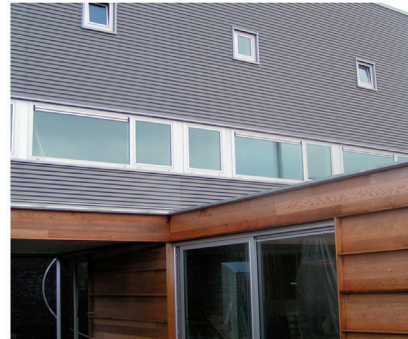
aluminium gevelbekleding type 22/76 ral 9007 (max. 40% van het geveloppervlak )
