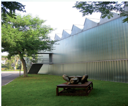
reglit gevelbekleding (max. 40% van het geveloppervlak )
