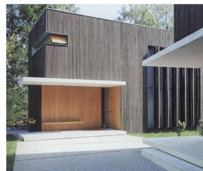
blank houten gevelbekleding (max. 40% van het geveleppervlak ) (larix of red cedar, FSC keur)
