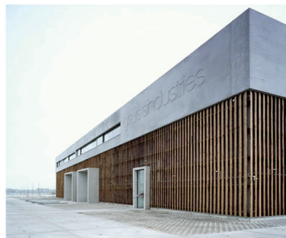
gevelbekleding beton (max. 40% van het geveleppervlak )
