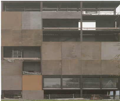
stalen gevelbekleding (platten) roestbruin (max. 40% van het geveloppervlak )
