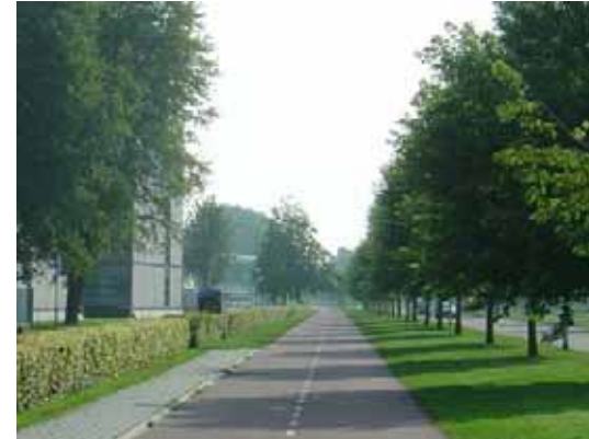
Referentie: Vrijliggende fietspaden in 2 richtingen
