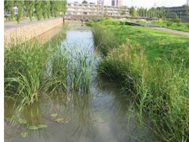
Referentie: Voorzieningen voor opvang van regenwater op het bedrijventerrein
