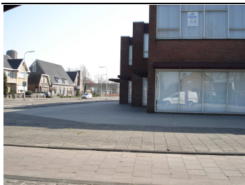
Figuur 3.1 (Voormalige) kantoorpanden aan noordzijde van het terrein
