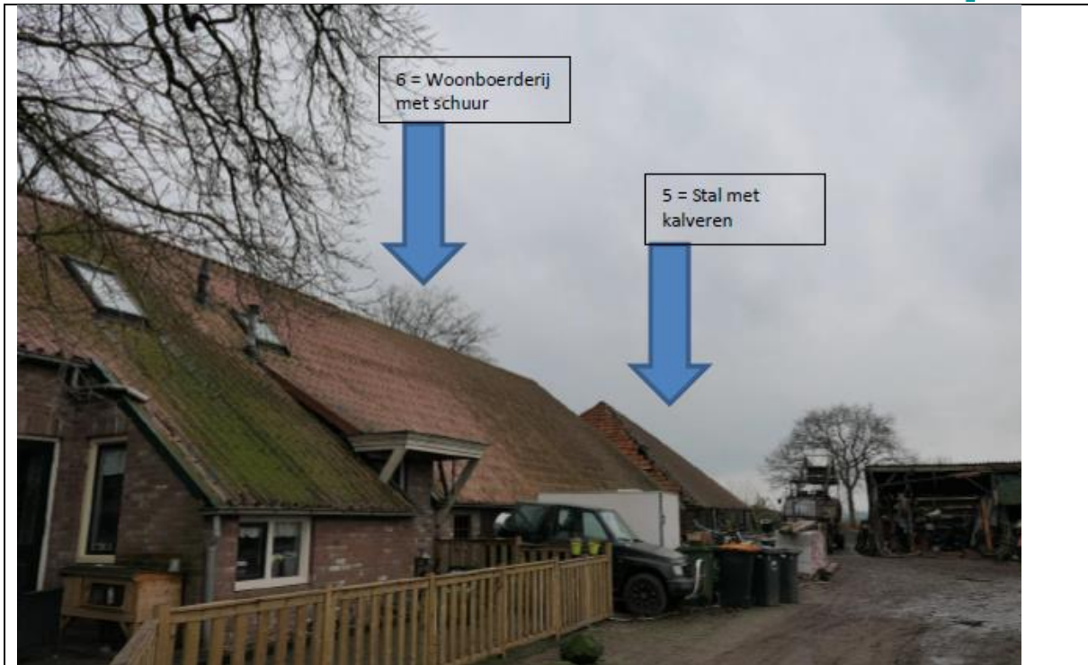
Foto 2.4 Woonboerderij met schuur, met daarachter de stal met kalveren gezien vanaf noordoosten.
