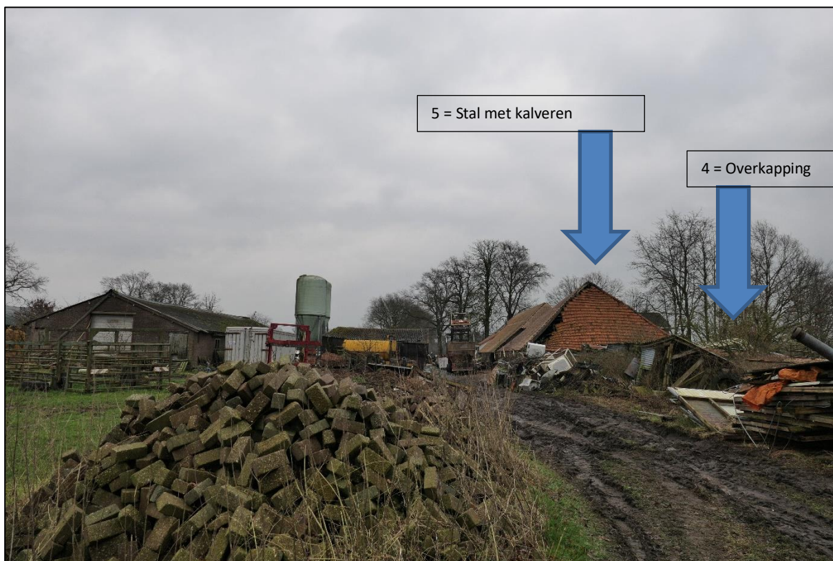
Figuur 1.3 Achterzijde terrein, gezien vanaf westen.
