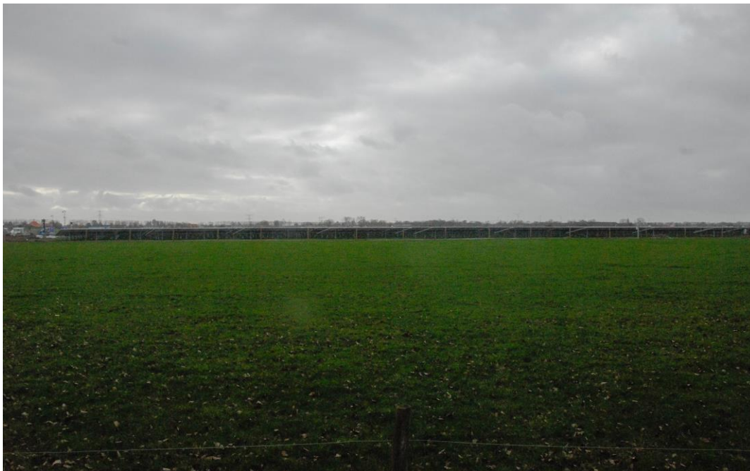
Gerealiseerd zonnepark Lingewal gemeente Bommel, achterzijde panelen gezien vanaf ongeveer 100m. Let wel: hier is nog geen beplanting aangebracht. De hardcore visuele waarneming beperkt zich tot een donker vlak. Door het zich visueel omlaagdrukkend vlak, blijft het zicht op het landschap behouden.
