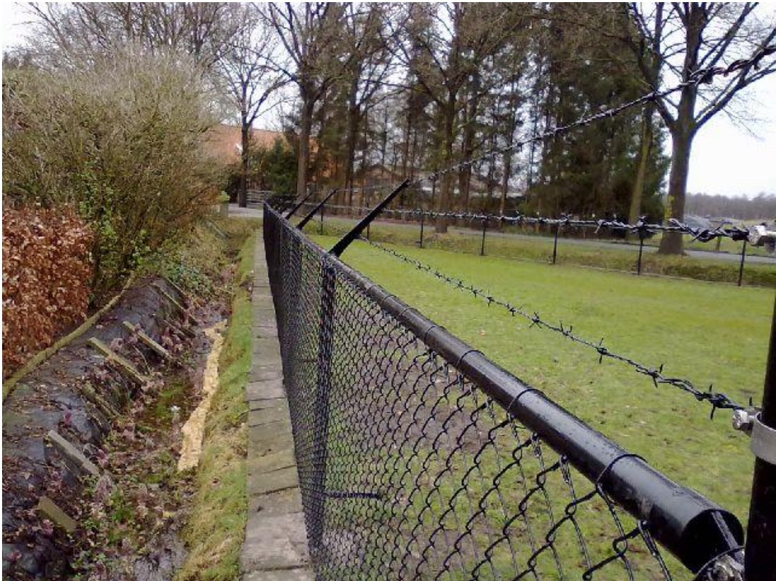
10-10-2018 gaashekwerk en poort ca 2 meter hoog plus draad
