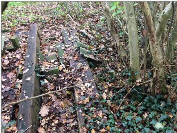
Foto 1: Asbestverdachte golfplaat op maaiveld boring 18
