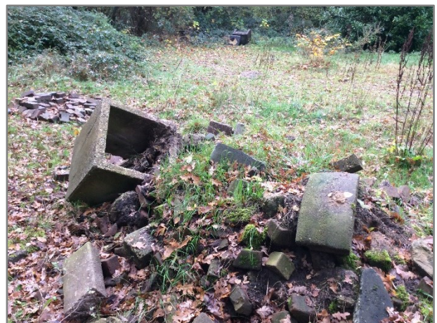
Foto 6: Puindepot op centrale deel onderzoekslocatie
