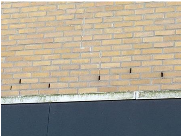
Potentiële invliegopeningen in de buitengevel van de kerk.
