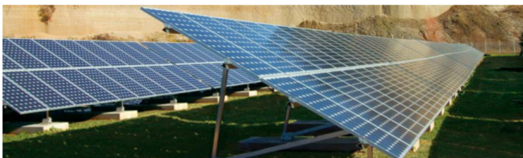
Afbeelding 15: Voorbeeld onderconstructie met betonvoeten
