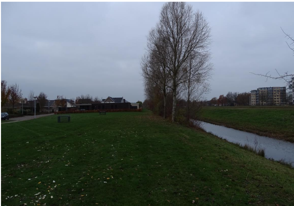
Figuur 2.4. Overzichtsfoto van de locatie waar vier walwoningen gerealiseerd gaan worden, gezien vanuit oostelijke richting.
