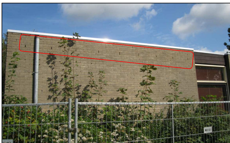
Figuur 2: Locatie Sneeuwbesstraat met open stootvoegen (rood kader). Dit zijn geschikte invliegopeningen voor vleermuizen (foto: M. van der Sluis).
