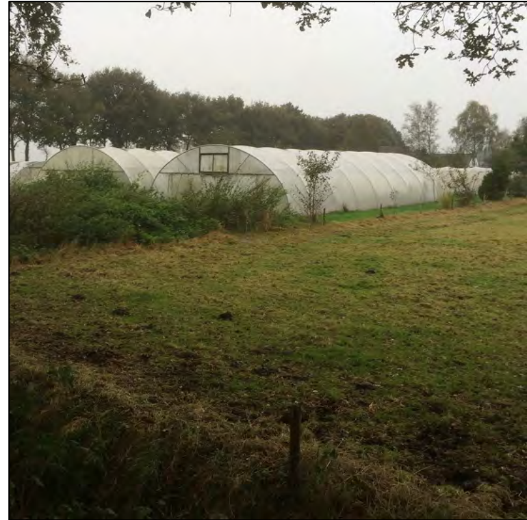
Figuur 10 Tunnelkassen worden gesloopt
