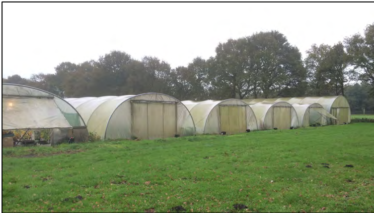
Figuur 12 Te slopen tunnelkassen
