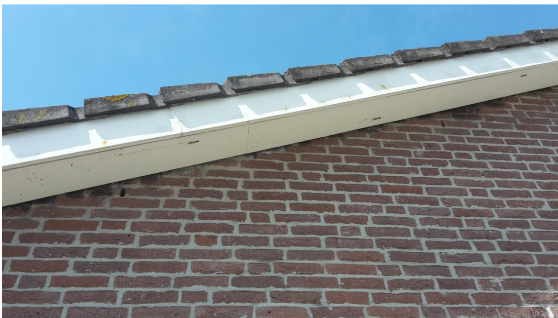
Figuur 1.4: Open stootvoegen van de te slopen school.
