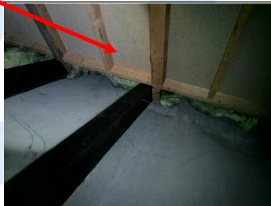
Foto 2 | Dakbeschot onder de pannen
