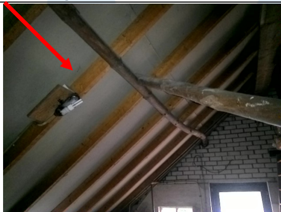
Foto 1 | Dakbeschot onder de pannen
