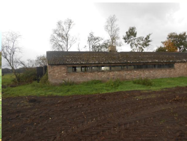
Oostelijke schuur, geplande nieuwbouwlocatie
