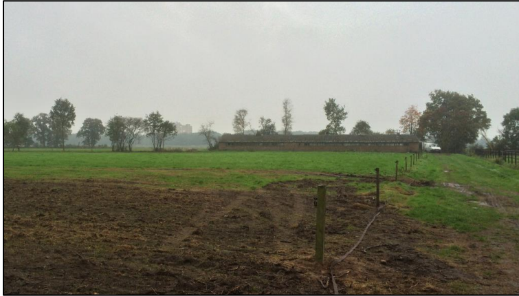
Figuur 13 Te slopen opstallen
