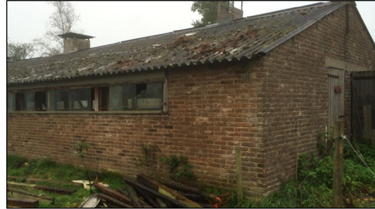
Figuur 15 Te slopen
