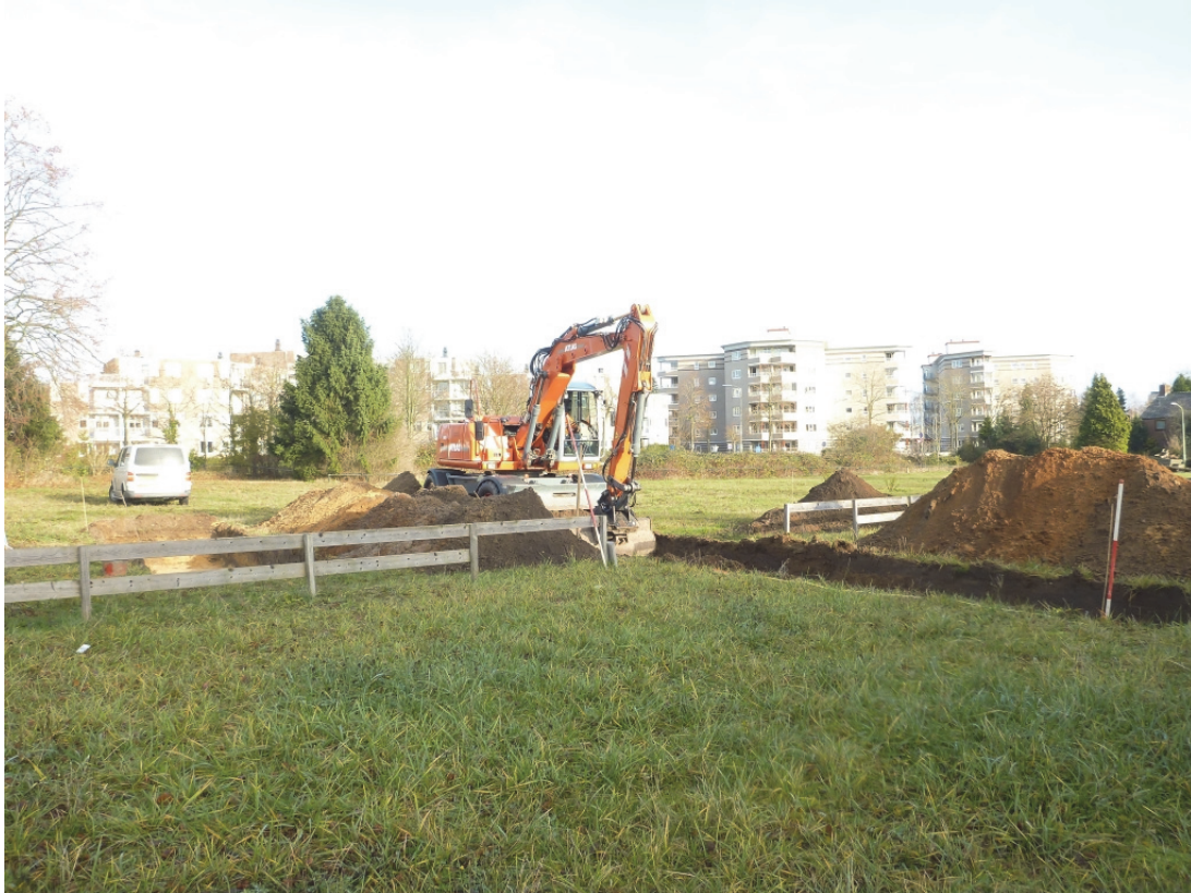
Fig. 4.1: De aanleg van werkput 2.
