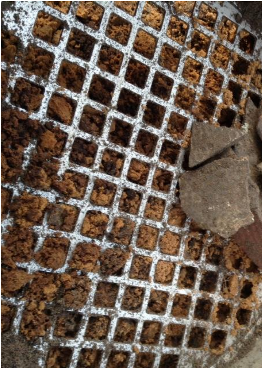
Foto 3: asbestplaatjes uit SL2
