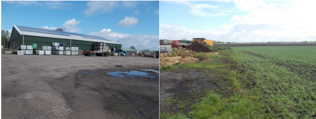
Foto 1 Impressie van het plangebied: verhard terrein achter huidige aardappelloods en grenzend daaraan het deel landbouwgrond met ingezaaid koren.
